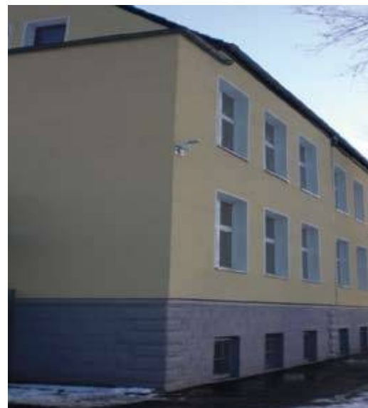
Dietrich-Bonhoeffer-Grundschule Fassade nachher
