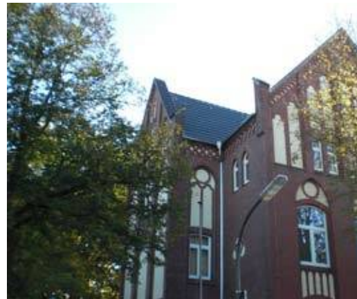
Schulmuseum – Dach nach der Sanierung
