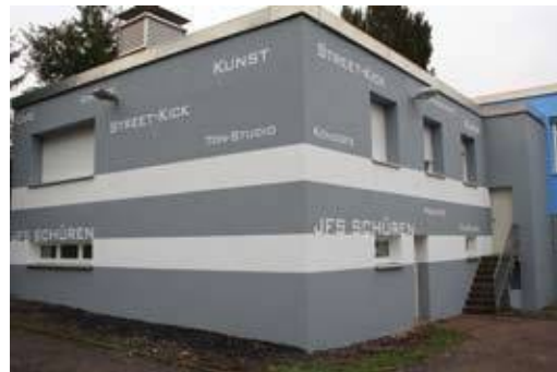
JFS Schüren Fassade nachher (Quelle: Büro Drahtler)
