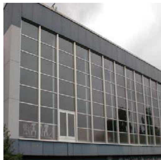
Hallenbad Hörde Fassade nachher (Quelle: Büro Drengenberg)
