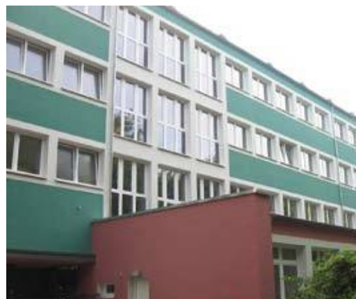
Gertrud-Bäumer-Realschule - Fassade nachher
