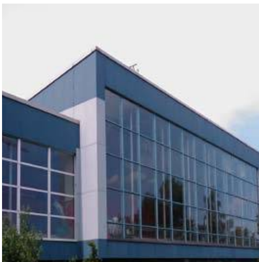
Hallenbad Hörde Fassade vorher (Quelle: Büro Drengenberg)
