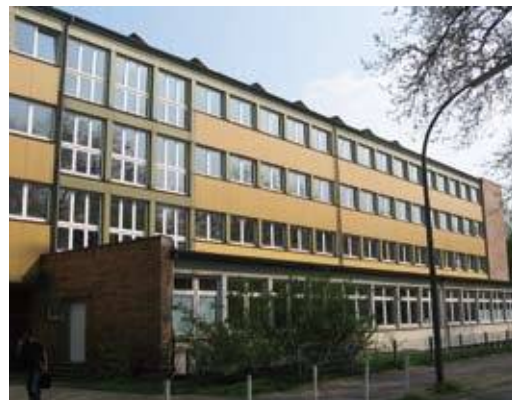
Gertrud-Bäumer-Realschule - Fassade vorher
