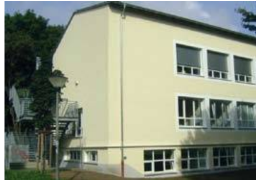
Albrecht-Brinkmann-Grundschule Fassade nachher
