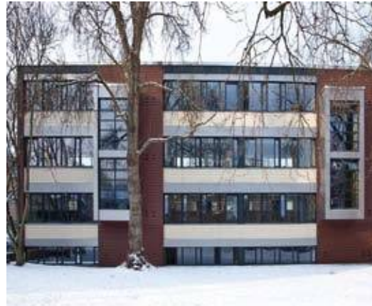
Stadtgymnasium Fassade nachher
