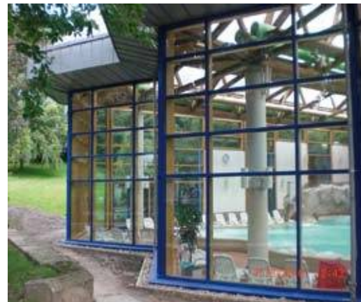
Revierpark Wischlingen Glasfassade nachher
