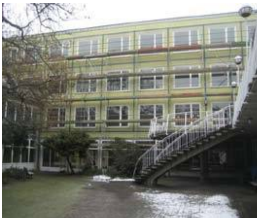
Fritz-Henßler-Haus Fassade vorher
