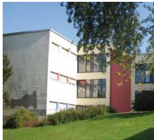
Hohwart-Grundschule nachher (Quelle: Büro Winkler + Partner)
