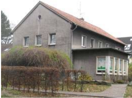
Ev. KiGa Aplerbeck Fassade vorher (Quelle: Büro Winkler + Partner)
