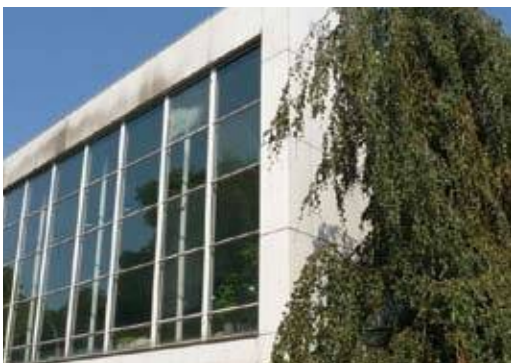
HB Brackel Fassade vorher (Quelle: Büro Drahtler)
