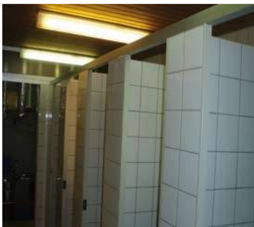
DKH Trennwände vorher
