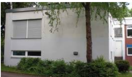
JFS Schüren Fassade vorher (Quelle: Büro Drahtler)
