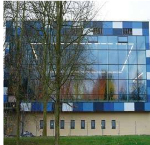
Hallenbad Mengede Fassade nachher
