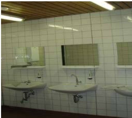
DKH Sanitär vorher
