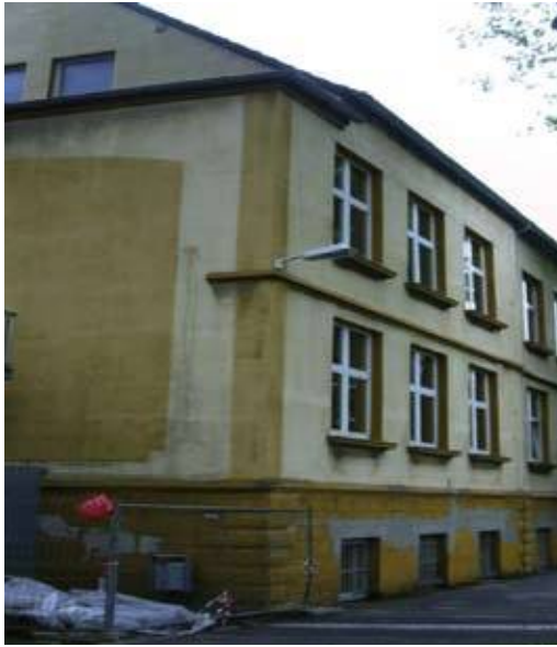
Dietrich-Bonhoeffer-Grundschule Fassade vorher
