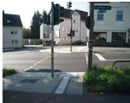
Barrierefreie Querung mit Signalanlage
