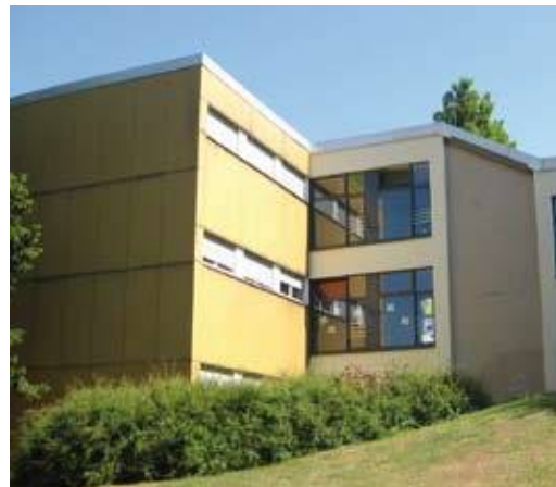
Hohwart-Grundschule vorher (Quelle: Büro Winkler + Partner)
