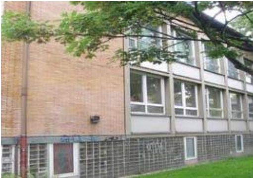
Albrecht-Brinkmann-Grundschule Fassade vorher
