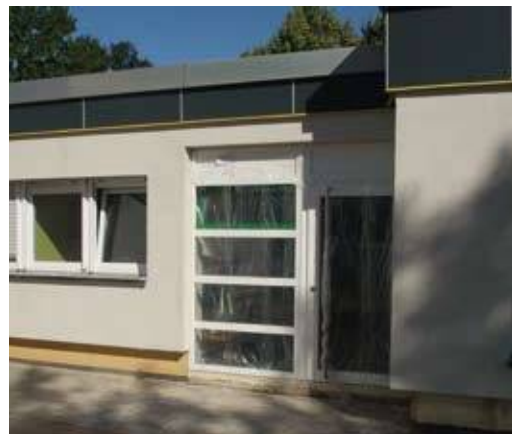
TEK Brechten Fenster Türen neu
